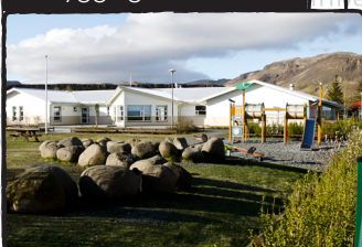
Viðbygging við Óskaland
